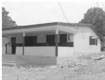
Die Krankenstation in Klonou bei Kpalimé ist kurz vor der Fertigstellung.
